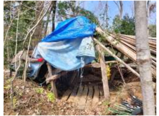
改修前の物置
