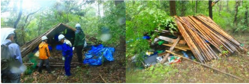
屋根覆いが飛んだ物置
