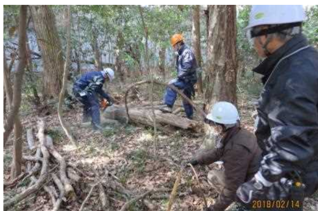
倒木の処理作業
