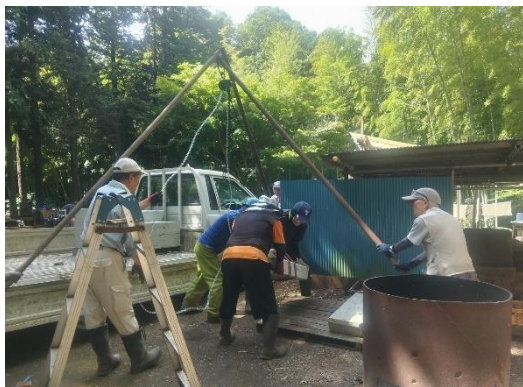
20260617 炭窯改修で大谷石を降ろす
