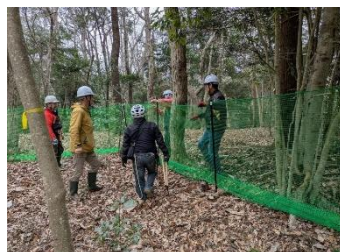
上部にロープを通して補強
