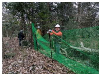
支柱を設置しネットを張る
