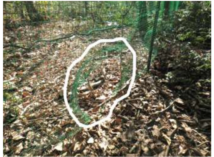
植生保護柵に開いた穴（白線で囲んだ部分）
