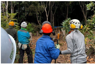
チルホールにて牽引
