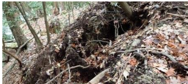
北側斜面の倒木による崩壊
