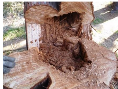
内部はすっかり腐食していた
