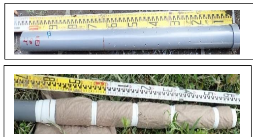
図3 上はフィルターを巻く前、下は設置前の井戸の管 上写真の管に孔が空いている0.6mから右がスクリーン
