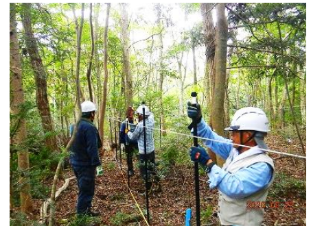
支柱が一直線に並び
