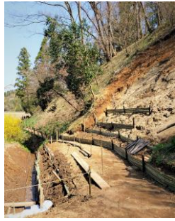
崩れた斜面を復旧中
