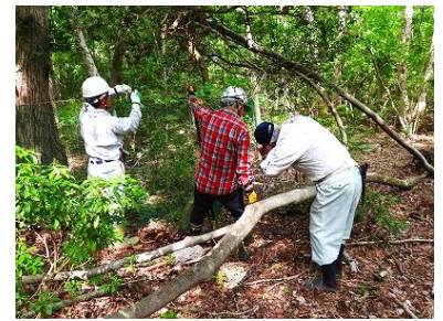
植生保護柵補修
