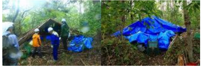
台風で倒壊した物置(9/16 坂本) 応急処置で修復後(坂本)
