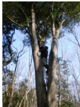
転落警戒しながら据付け
