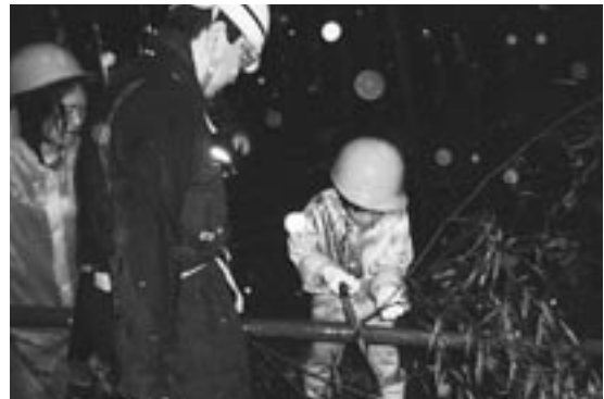
竹の除伐作業
