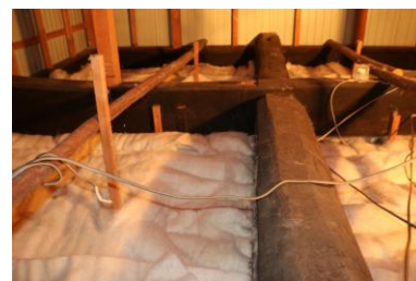
天に羊毛を敷き詰め断熱
